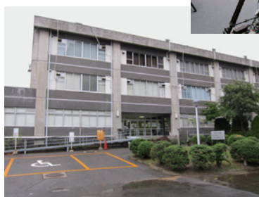
工学部7号館B棟
